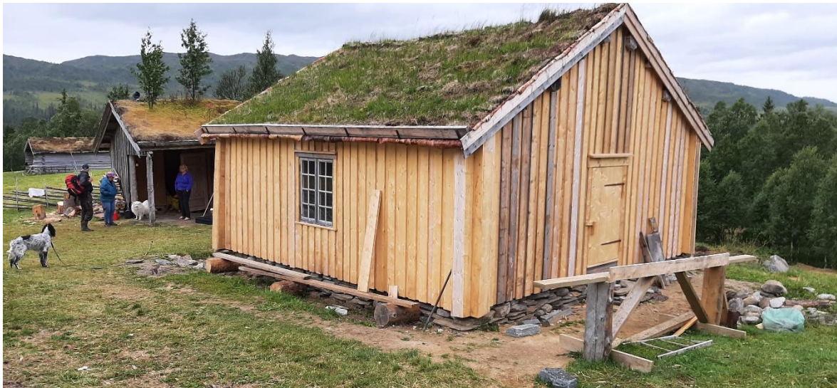
Seterstua ferdig restaurert utvendig. Foto: Ottar Bergli.
